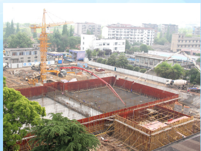
南湖水厂一期改造工地
