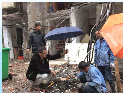
金丰园小区管网抢修
