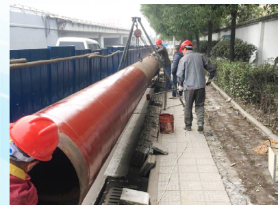
太岳路水管网改造工程
